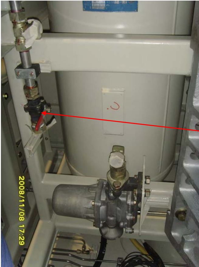
图 8：截止阀 A10（关闭位）
